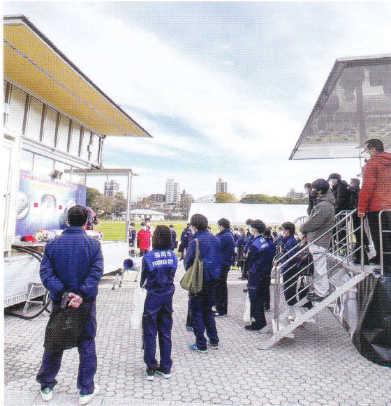
オメガライナー工法の拡径デモ施工（福岡市）
