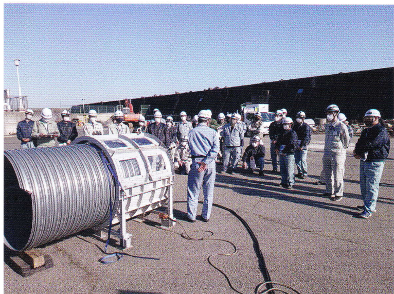
自立管製管工法を若手職員に紹介
